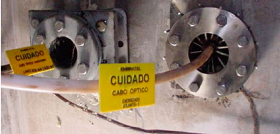
Acomodação da Caixa de Emenda na Caixa de Ancoragem na parede
